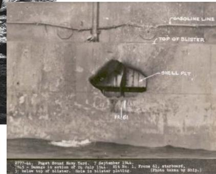
↑圧倒的な戦力差にもかかわらず日本軍も果敢に反撃した。右の写真はサイパンの隣の島、テナアン島を米軍が攻撃する際、日本軍の6インチ砲の攻撃が、戦艦「コロラド」に与えた損傷。
